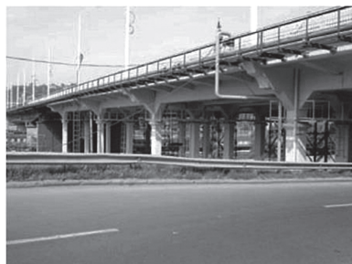
Рис.5.5. Мост-путепровод на проспекте Стачки в г. Ростов - на - Дону . Ремонт бетонных конструкций проведен с применением полиуретановых покрытий ВМП
