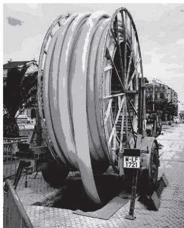
Рис.5.18. Метод протаскивания предварительно профилированной полиэтиленовой трубы «U-лайнер»:
