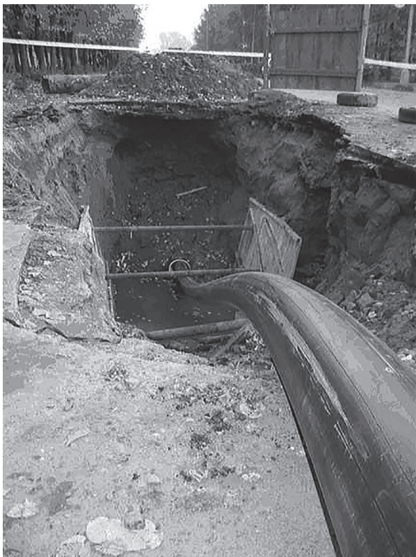
Рис 5.17. Вид входного котлована при ремонте способом протаскивания нового пластмассового трубопровода
