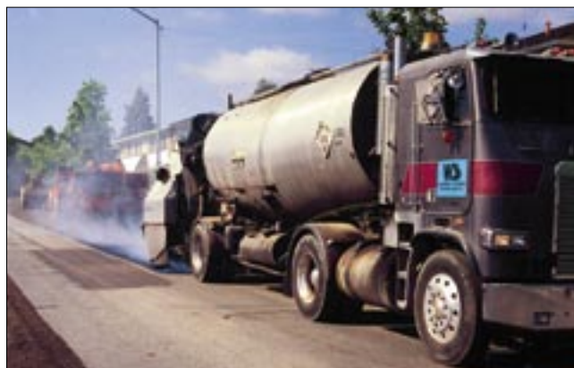
Устройство поверхностной обработки с применением резинобитумного вяжущего.
