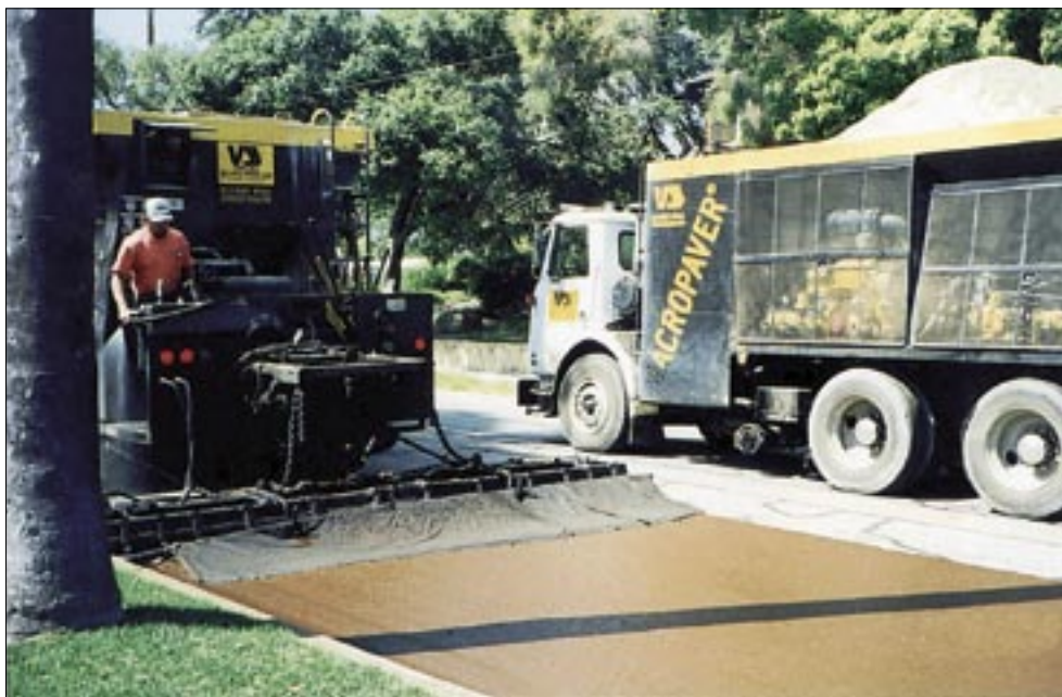
Укладка Микросюрфейсинга.
