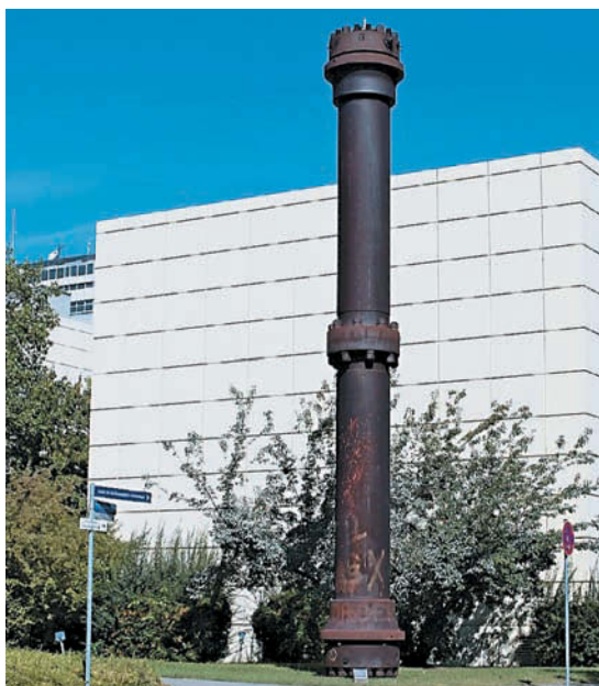
Колонна синтеза аммиака, построенная в 1921 г. фирмой BASF, ныне находится на территории университета г. Карлсруэ, Германия.
