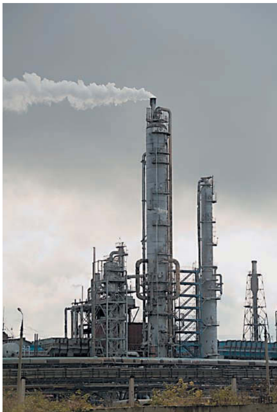
Колонна синтеза аммиака.
