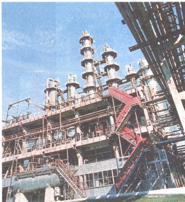
Один из цехов Нижнекамского нефтехимического производственного объединения
