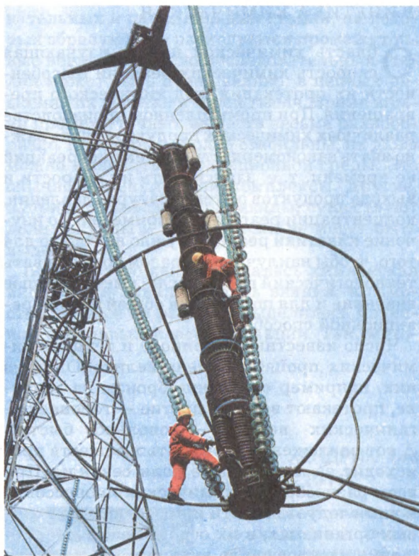
Из керамики изготавливают изоляторы для высоковольтных ЛЭП (вверху) и другие изделия, используемые в технике, строительстве, быту и т. д.
